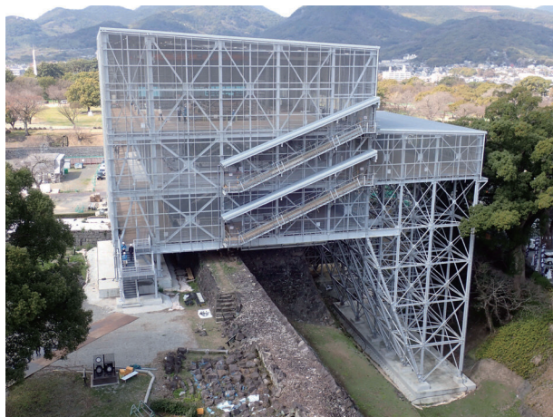
宇土櫓五階櫓復旧工事の素屋根
