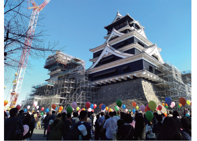
天守閣の復旧工事(鯨瓦設置の特別公開)
