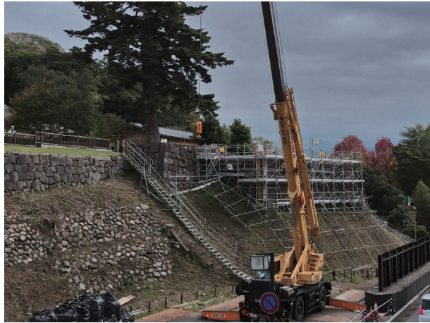
能登半島地震の復旧事業（史跡金沢城跡）
