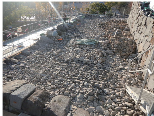
石垣の耐震補強例（飯田丸五階櫓石垣）
